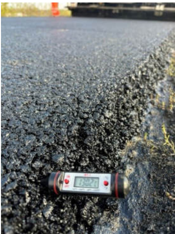
10. ábra Hőmérséklet csökkentett (WMA) kopóréteg, 09:35
