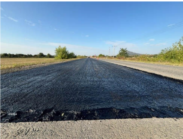
9. ábra A próbaszakasz bitumen emulzióval takart kötőrétege, 08:30
