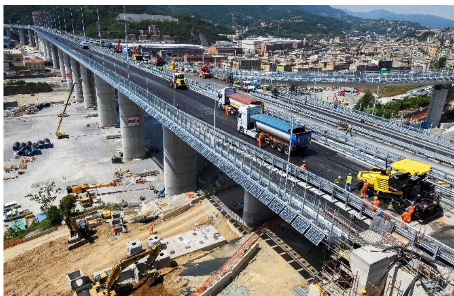
Kép 5 – Kivitelezés a San Giorgio hídon, Genova
