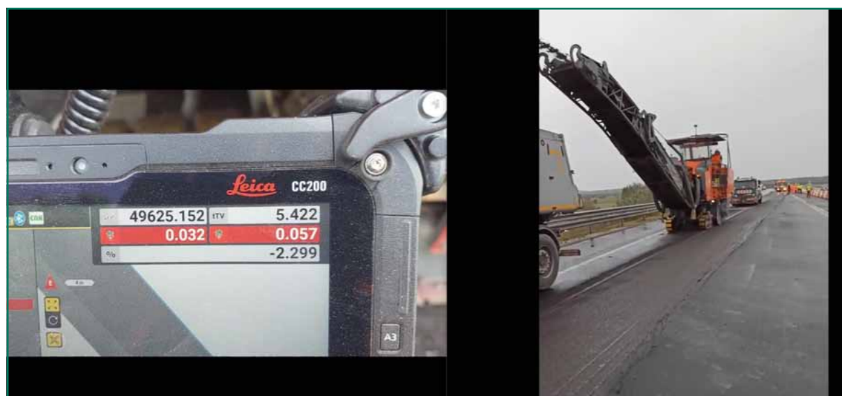
8. ábra Bal oldalon a marógép panelja mely a modell alapján a tervezett marási vastagságot mutatja a maródob jobb, és bal oldalán, jobb oldalon a marógép látható munkavégzés közben
