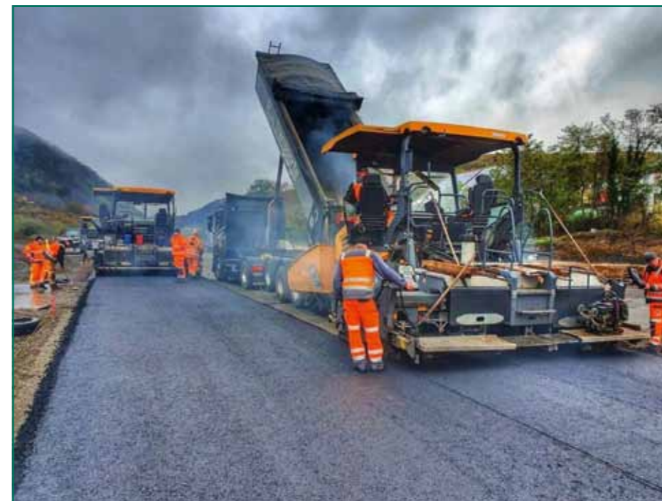
1. ábra: Aeroszol és gőz expozíció hengerelt aszfalt hagyományos építése során
