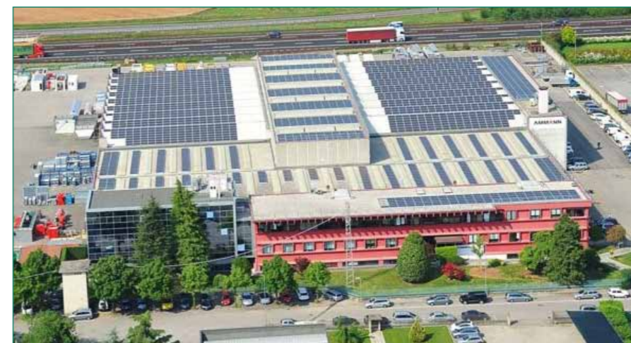
1. kép - Az AMMANN keverőtelepgyártó üzeme Bussolengo-ban
