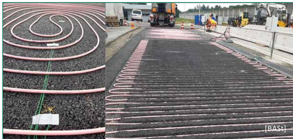
2. ábra: a csőregiszterek elrendezése spirális és szerpentin mintázatban
