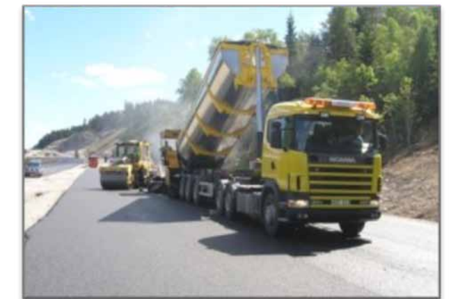
19. ábra: Szigetelt kerek aljú kialakítású teherautó (Asfaltskolan, 2020).
