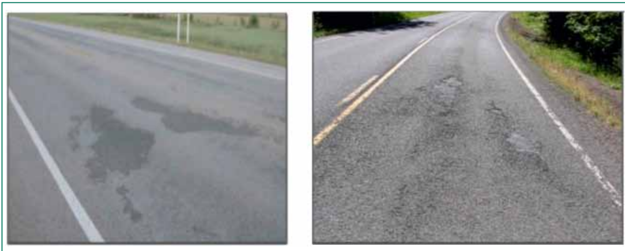
9. ábra: A víz stagnálása esős esemény és a burkolat romlása miatt a hőmérséklet-szegregáció miatt (Pavement Interactive, 2019; Sebesta, Scullion, Saarenketo, 2013: 9. o.).
