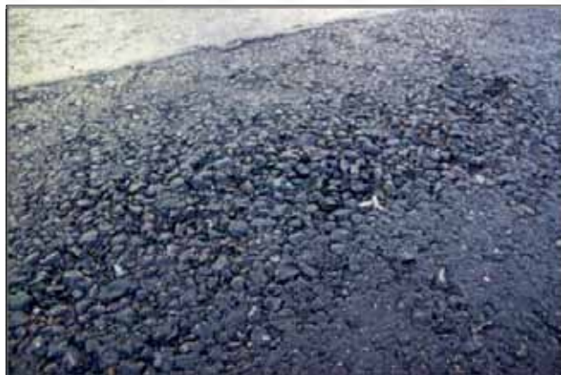
3. ábra: Példa a durva szemek nagy arányú anyagszegregációjára (Rošer, 2020).
