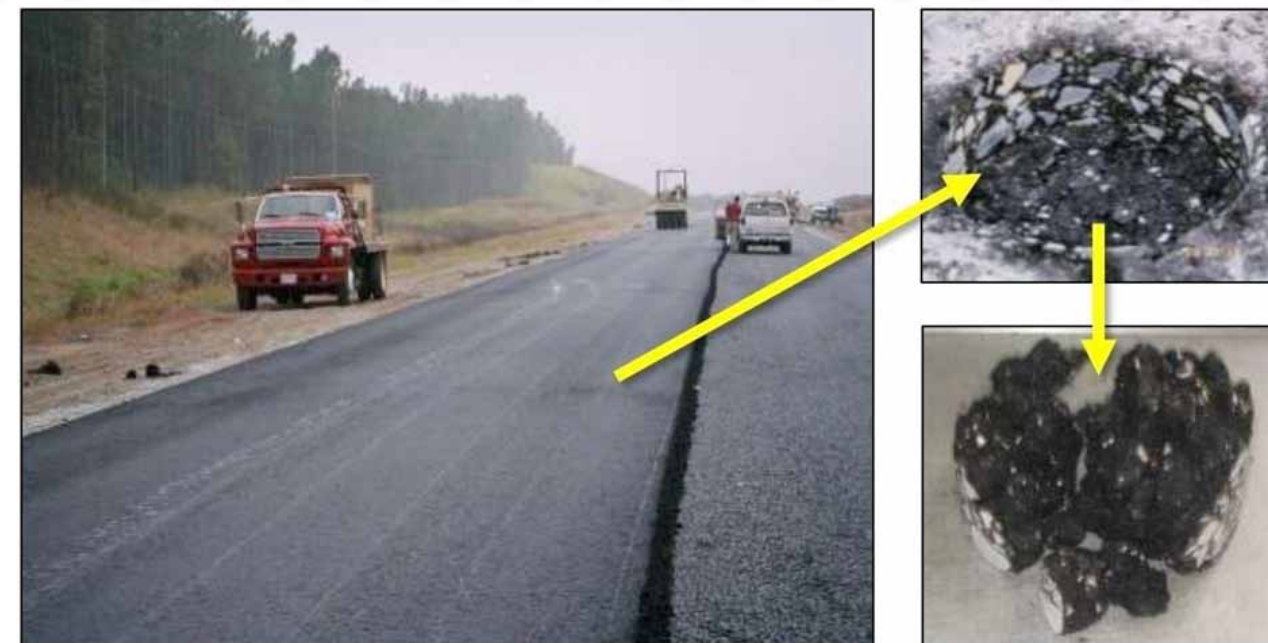
11. ábra: A vett magminta szétesése a magas szintű szegregáció miatt (Von Quintus, Reiter, 2018: 5. o.).
