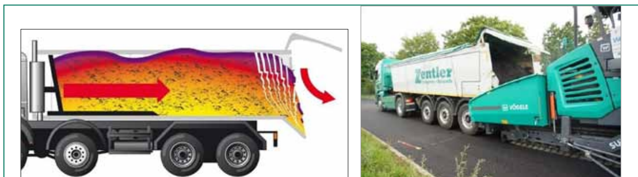
21. ábra: Az aszfaltkeverék kipakolása push-off technológiával (Rošer, 2020)
