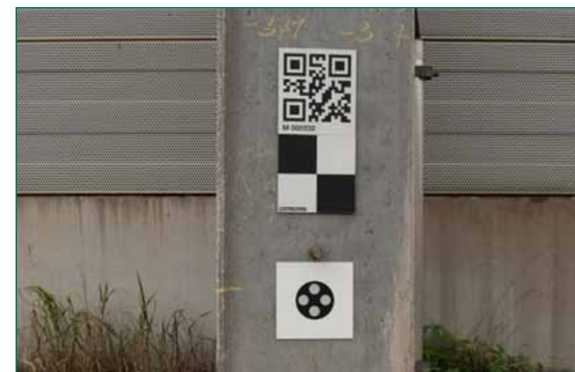
6. ábra Felsővezeték-tartó oszlopon bemért fix-pont és a leolvasandó QR-kód
