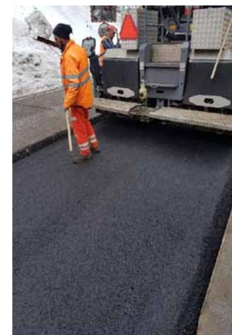
ACF22: 100% RAP + 4,5% REJUVENÁTOR a bitumenre vonatkoztatva
