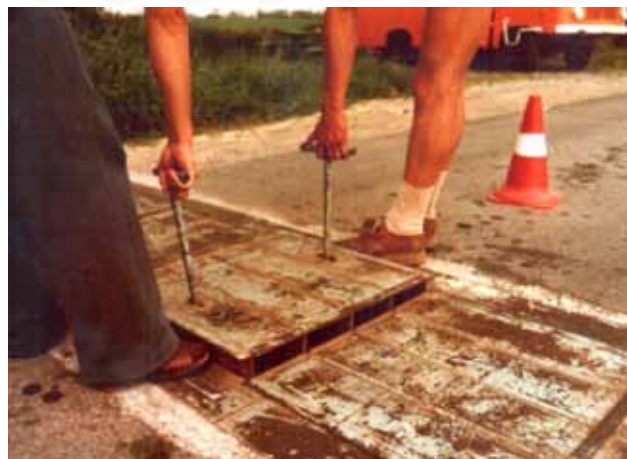
12. kép: Süllyesztett tengelyterhelés mérő, az 1970-es években
