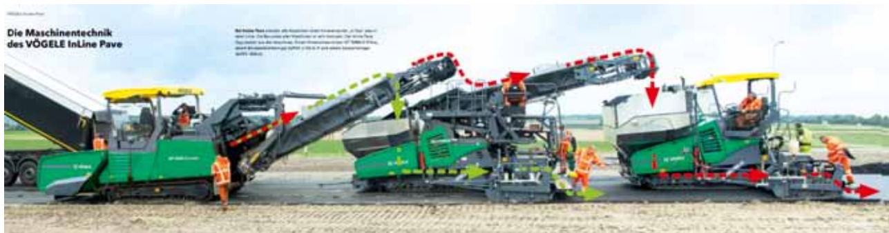
5. ábra InLine Paving beépítési technológia munka közben [4.]
