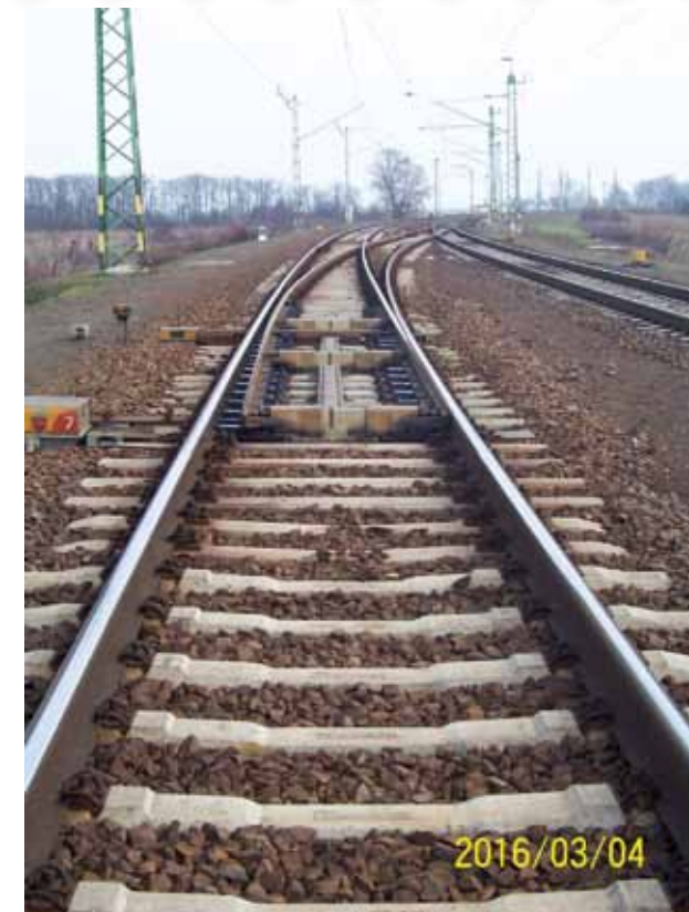
8. kép Ívesített kitérő
