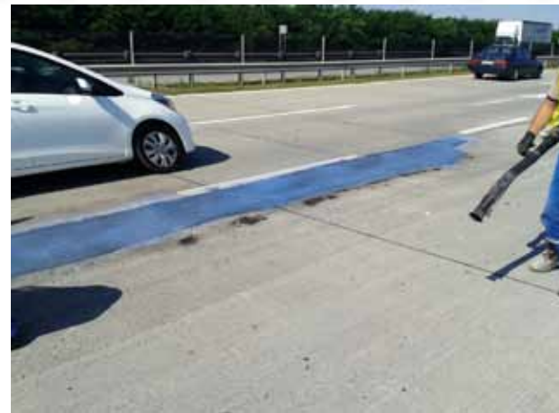
4.kép: felületi bevonattal javított hiba utókezelése
