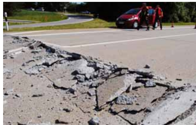
2. kép: Tábla robbanás a magas hőmérséklet hatására
