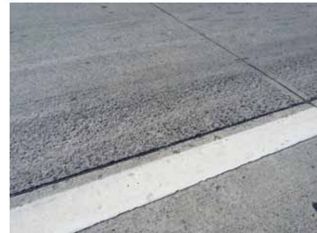
5.kép: felületi bevonattal javított hiba forgalom hatása után
