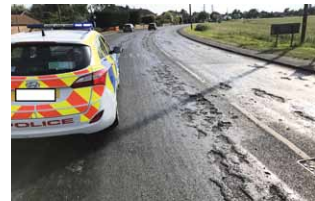
1. kép: Réteg leválás a magas hőmérséklet hatására
