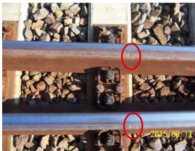
6. kép Csillagpontok ellenőrzése
