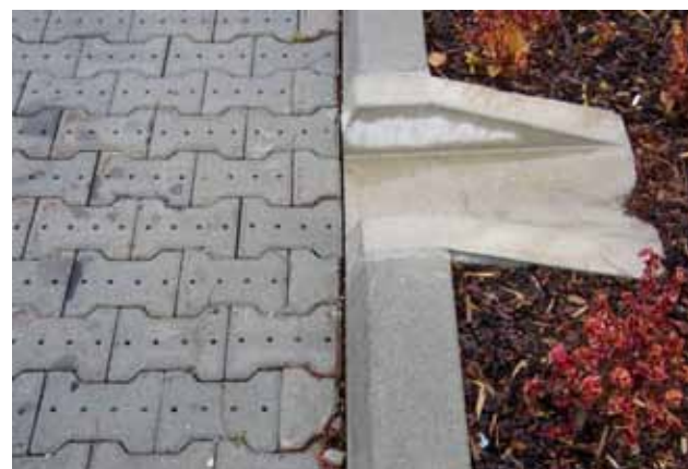
1. kép: Vízáteresztő burkolat: a csapadékvíz nagyobb mértékű áteresztése a térkőburkolat szerkezeti gyengítésén keresztül
