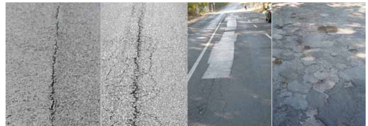
1. ábra: Leromlás folyamata aszfaltburkolaton [saját kép]
