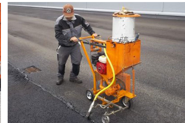
6. ábra: Hézagkitöltés barkács gépekkel, meleg kitöltés (a) és kitöltés hideg technológiával (b) [saját kép]
