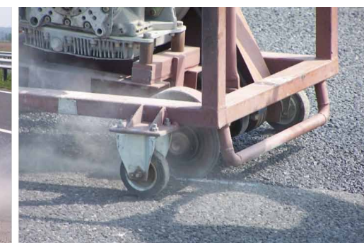
9. ábra: A hézag bővítése szárazon, gyémánt tárcsával [saját kép]
