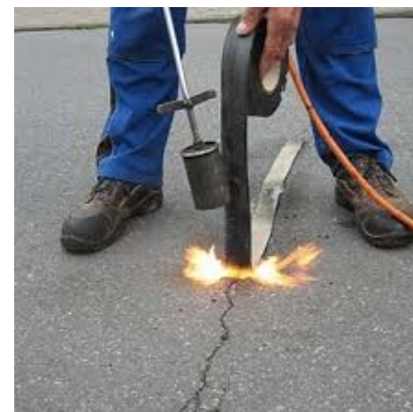
5. ábra: Repedést lefedő szalag alkalmazása [saját kép]
