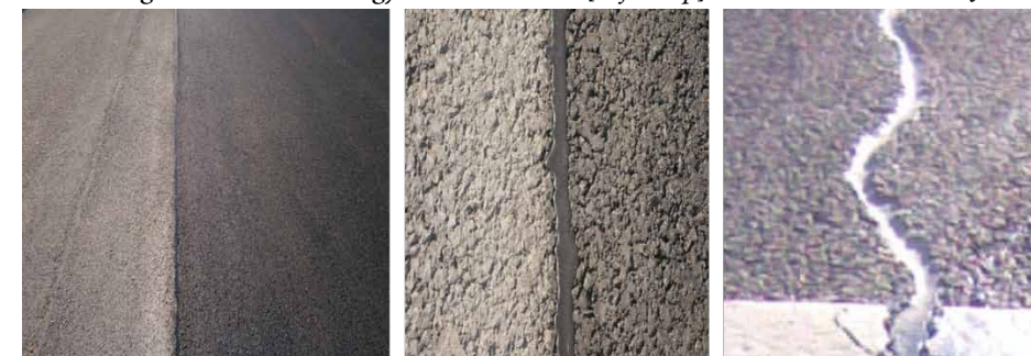
11. ábra: Az elkészült hézagkitöltés [10]
