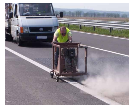
9. ábra: A hézag bővítése szárazon, gyémánt tárcsával [saját kép]
