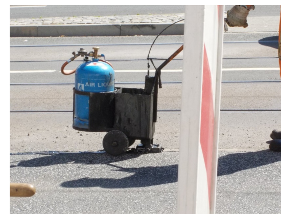
6. ábra: Hézagkitöltés barkács gépekkel, meleg kitöltés (a) és kitöltés hideg technológiával (b) [saját kép]
