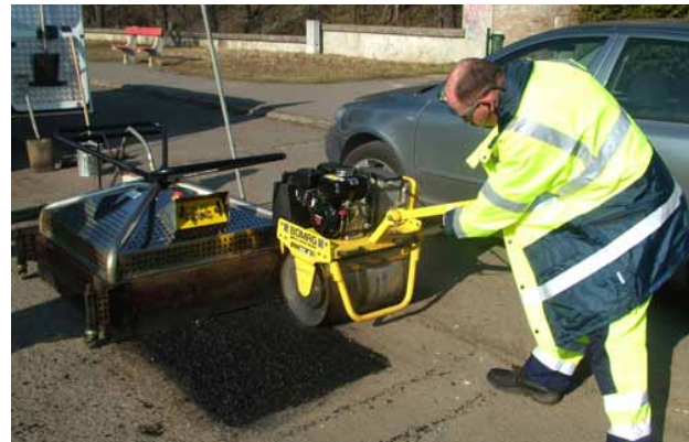
14. ábra: Kézi bedolgozás [12]
