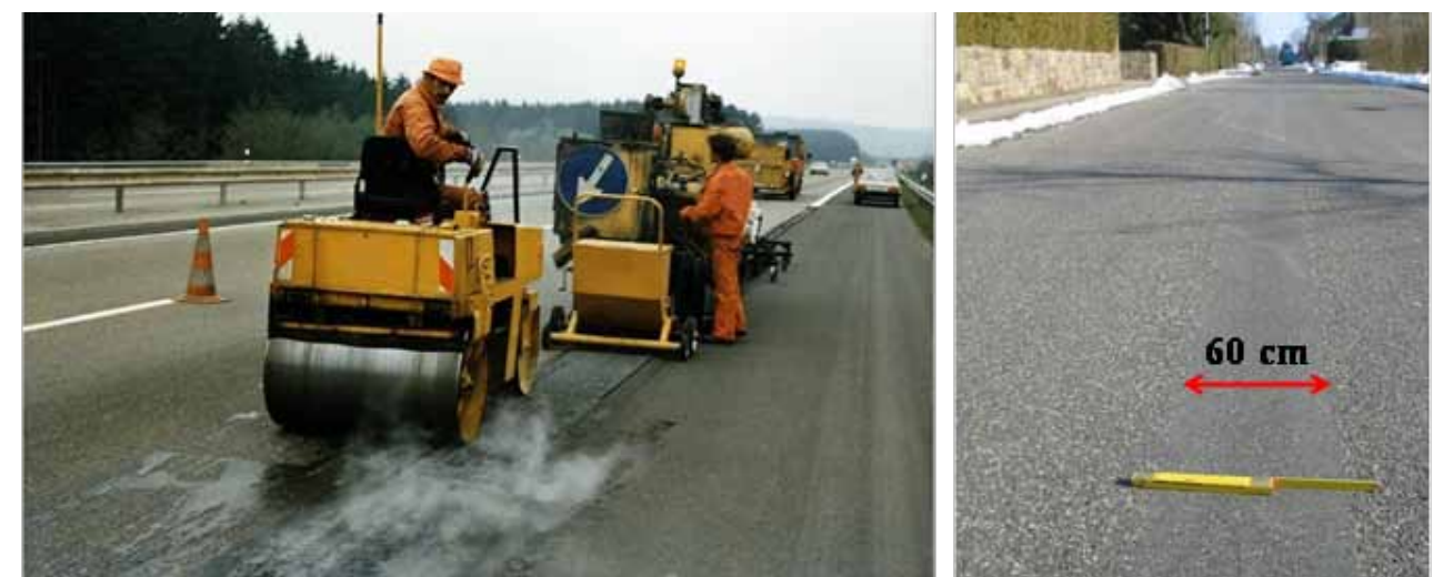
18. ábra: Hengerlés és az elkészült burkolat [9]
