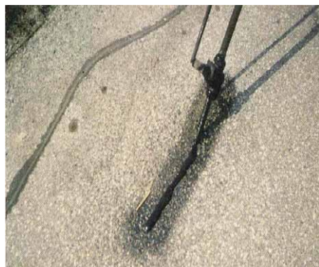
7. ábra: Keskeny és széles papucsos repedés kitöltés [saját kép]
