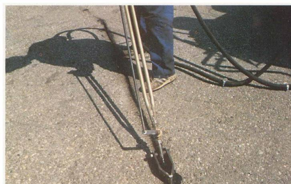
7. ábra: Keskeny és széles papucsos repedés kitöltés [saját kép]
