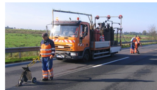
12. ábra: Bedolgozás széles papucsos fejjel [saját kép]
