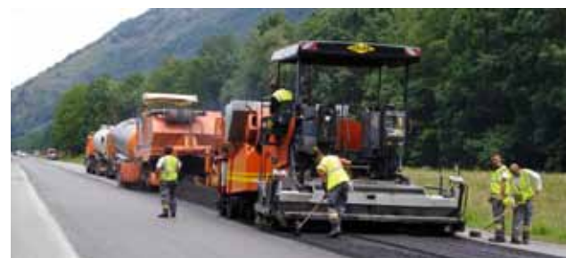
1. ábra: Bitumenes kötőanyaggal készült hideg recycling (Novacol) kivitelezés közben
