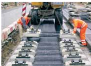
5.ábra: A talpgerendák elhelyezése a kész aszfalt alátámasztó rétegen [6.]
