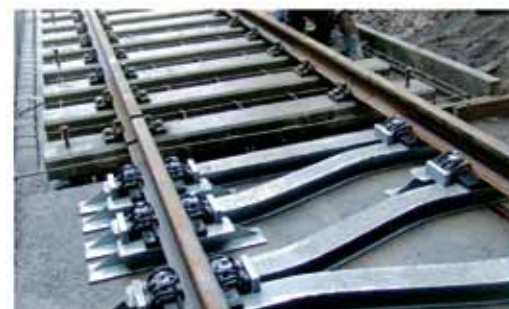
3. ábra: Két példa a SATO rendszerre. Az alsó ábrán y-acél talpgerendák az aszfalton [5.]
