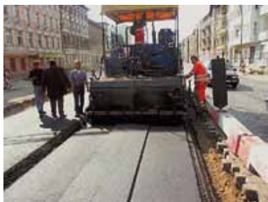
4.ábra: Finisher egy speciális profilú simító gerenda teríti az ATD felső rétegét, hogy az később stabilan helyén tartsa a talpgerendákat (forrás Voegelé)
